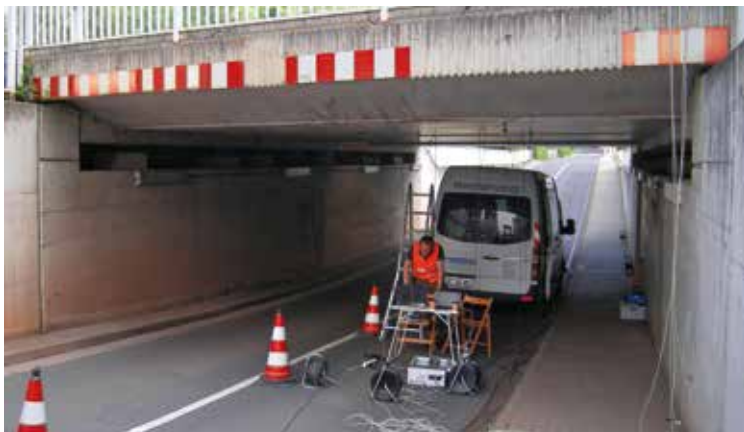
Schwingungsmessungen an Brückenbauwerken und Bewertung der Bausubstanz
