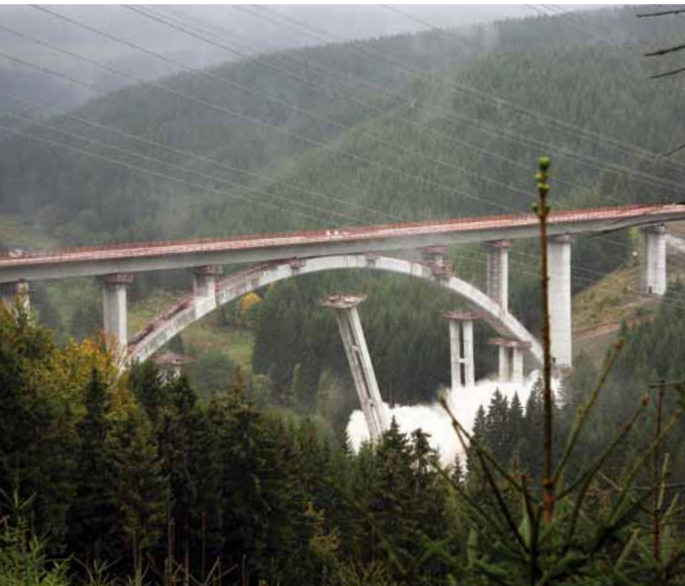
Der Bogen steht frei, die Hilfspfeiler werden gesprengt, 2010
