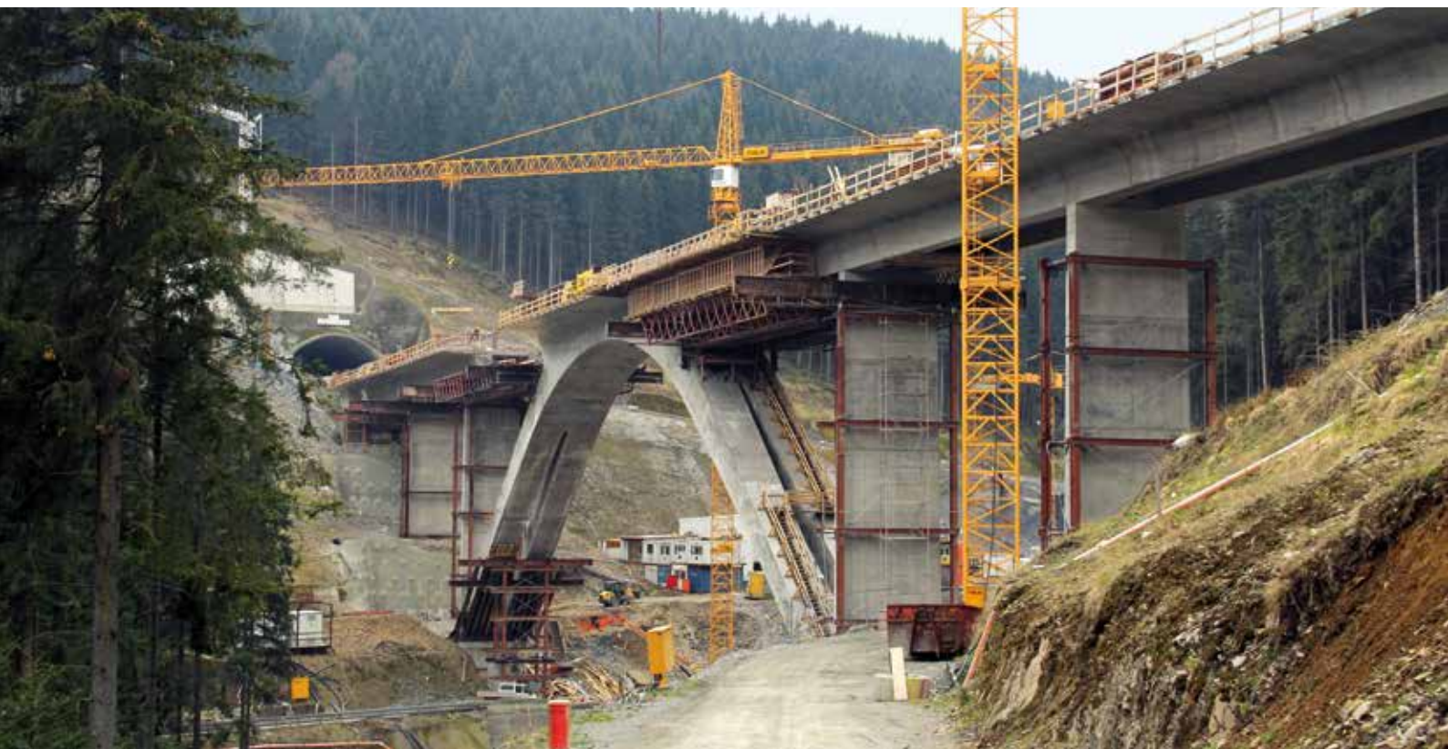
Grubentalbrücke April 2012, gut erkennbar: die monolithische Verbindung von Pfeilern und Überbau
