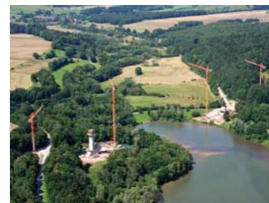
Bild 14: Talbrücke Froschgrundsee - Beginn Bogenherstellung, DB ProjektBau GmbH
