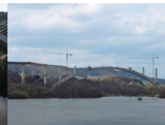
Bild 16: Talbrücke Froschgrundsee - Taktschieben Überbau, DB ProjektBau GmbH
