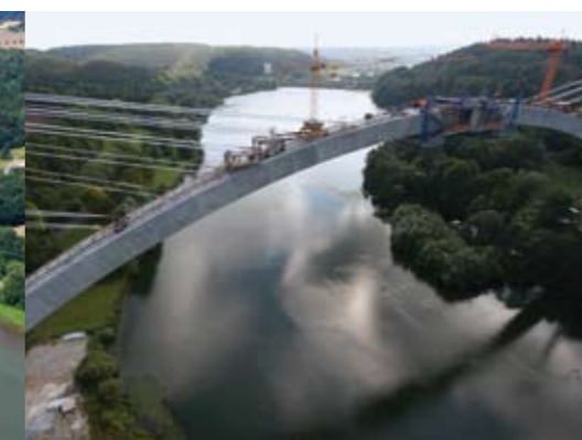
Bild 15: Talbrücke Froschgrundsee - Bogenschluss, DB ProjektBau GmbH
