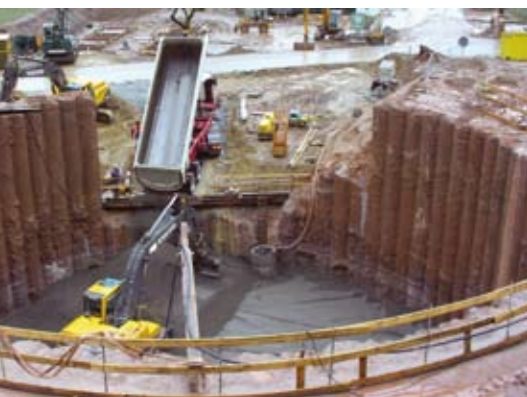
Bild 17: Grümpentalbrücke – Einbau Magerbeton Achse 90, DB ProjektBau GmbH
