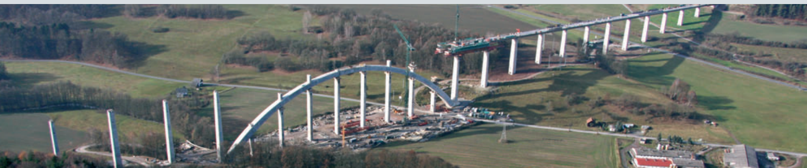
Eisenbahnüberführung Grümpentalbrücke im Bau, November 2009
