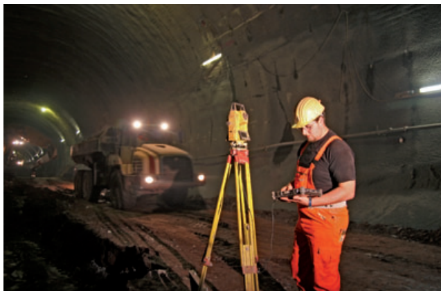
Vermessung im Tunnel Müß
