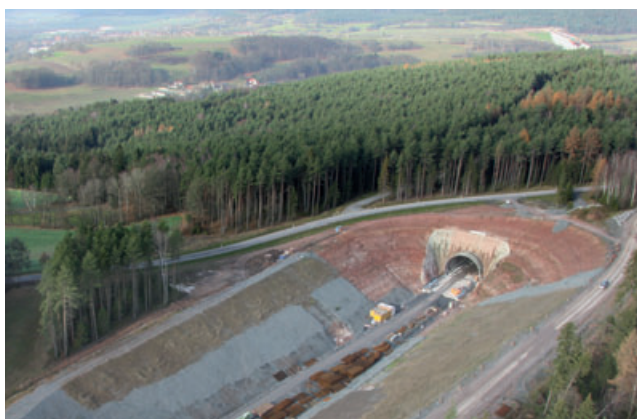
Nordportal Tunnel Baubleite
