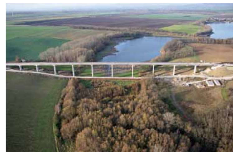
Scherkondetalbrücke Südseite November 2009
