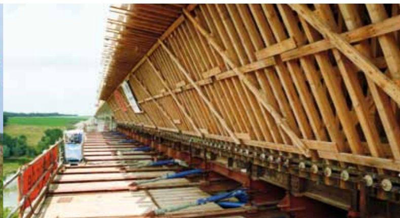
Vorschubrüstung und Überbauschalung
