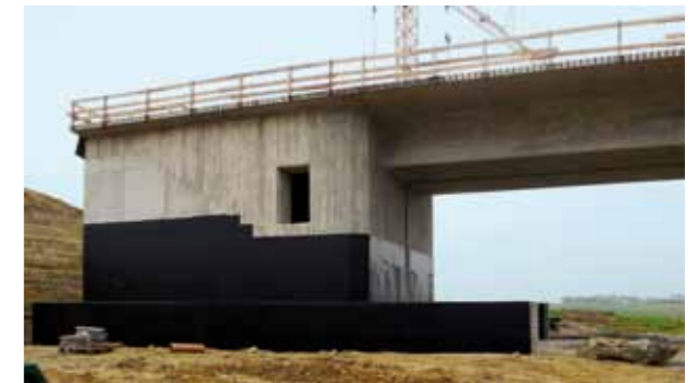
Widerlager Achse 0 Bauzustand
