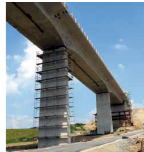
Pfeiler mit Lagern Achse 11 und 12
