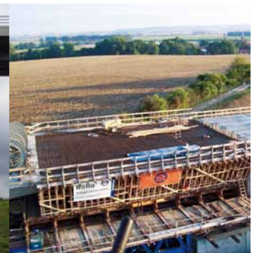
Betonage des letzten Überbautaktes
