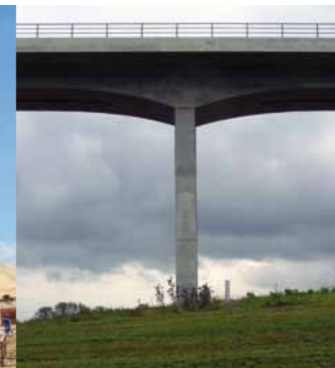
Pfeiler mit monolithischem Anschluss
