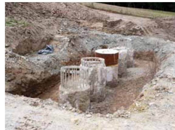
Bohrpfahlreihe Achse 4
