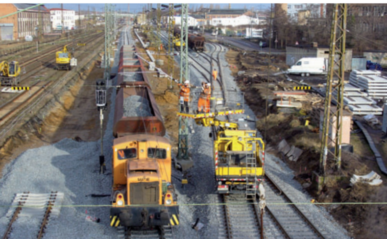
Gleisbauarbeiten an der Südanbindung Halle
