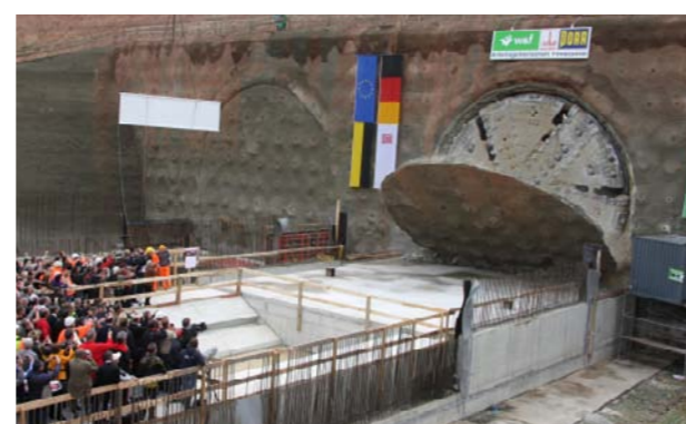
Tunneldurchschlag am Nordportal, September 2009
