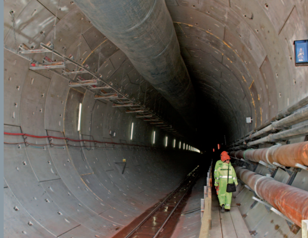
Titelfoto: Baustelleneinrichtung mit Tübingfabrik Portal West
