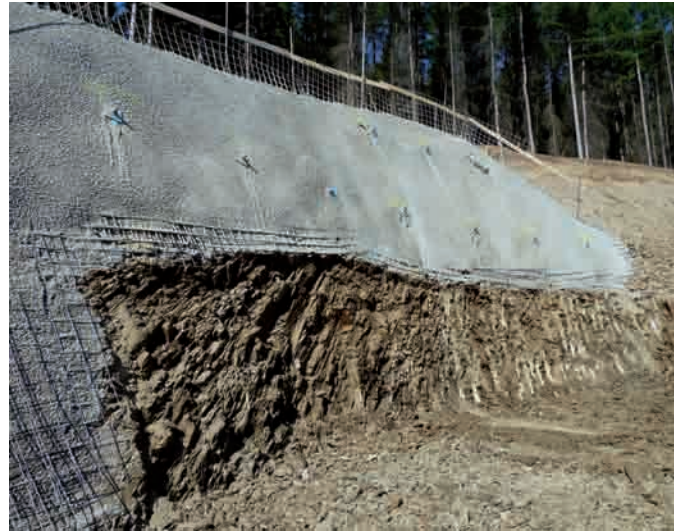
Spritzbetonsicherung des Voreinschnittes am Südportal
