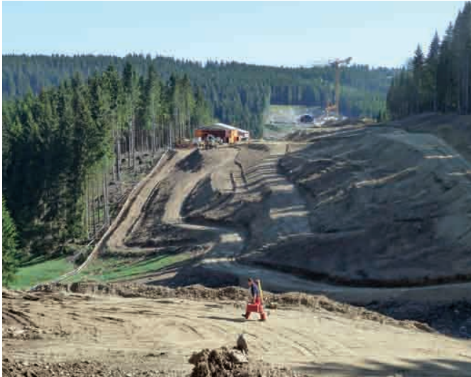
Baufeld Süd mit Blick auf das Nordportal Tunnel Masserberg
