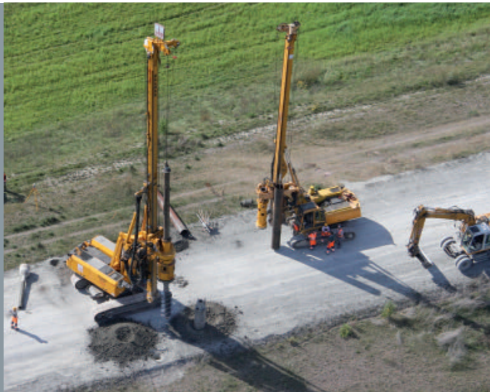
Fundamentgründungen für Oberleitungs masten Titel: Verlegung Feste Fahrbahn
