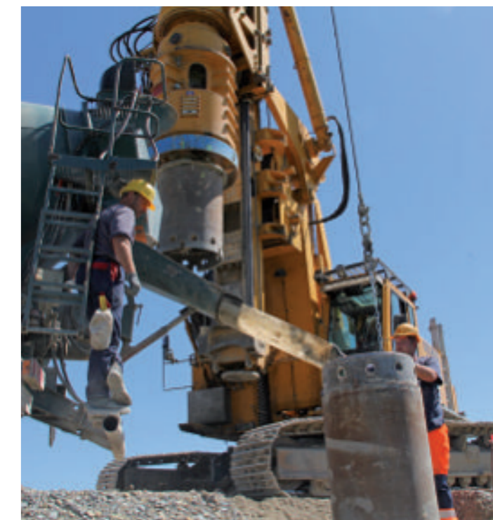
Vor dem Bau der Festen Fahrbahn: Herstellung der Oberleitungsmaste
