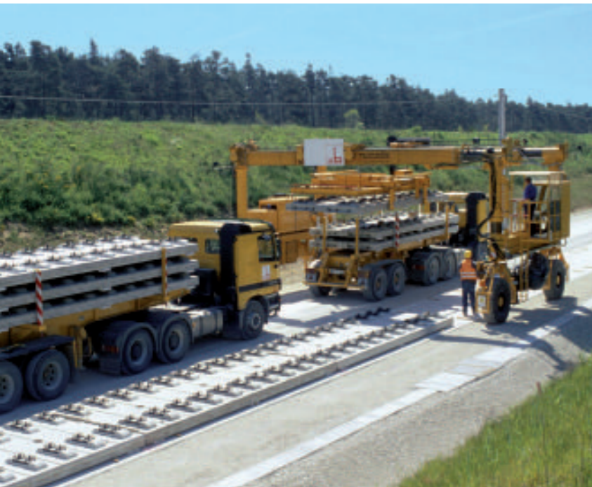
Verlegung Feste Fahrbahn
