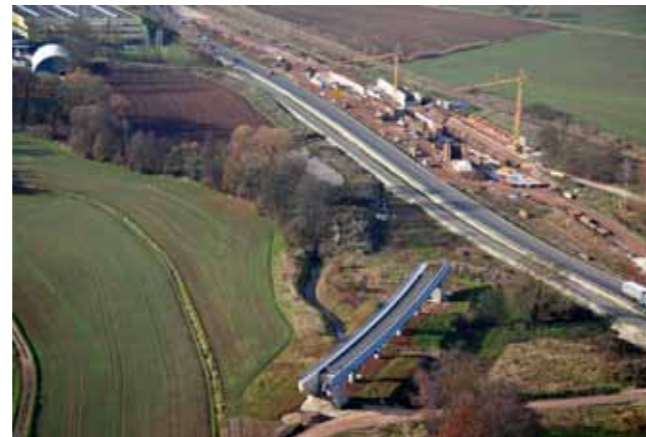
Einbindung Coburg Süd mit Füllbachbrücke und EÜ über die B303 im Bau, 2009
