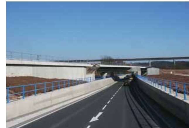
Im Trog abgesenkte Bundesstraße B303 unter der Brücke im Zuge der Verbindungskurve zur südlichen Anbindung an Coburg, 2011
