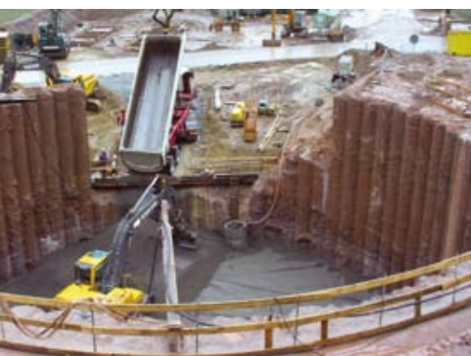
Bild 17: Grümpentalbrücke – Einbau Magerbeton Achse 90, DB ProjektBau GmbH
