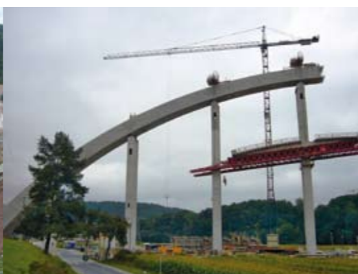
Bild 19: Grümpentalbrücke – Ablassen der Bogenrüstung nach Herstellung BA 4, DB ProjektBau GmbH
