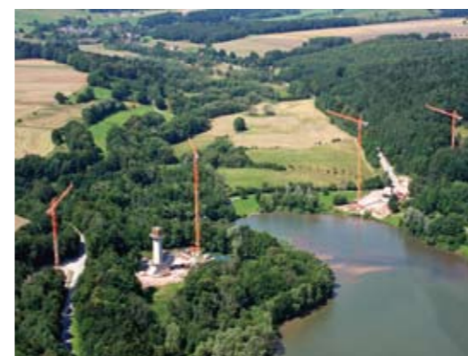
Bild 14: Talbrücke Froschgrundsee - Beginn Bogenherstellung, DB ProjektBau GmbH
