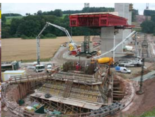
Bild 18: Grümpentalbrücke – Betonieren des Kämpfers Achse 90, DB ProjektBau GmbH
