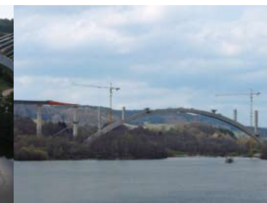
Bild 16: Talbrücke Froschgrundsee - Taktschieben Überbau, DB ProjektBau GmbH
