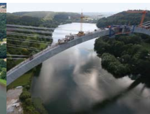
Bild 15: Talbrücke Froschgrundsee - Bogenschluss, DB ProjektBau GmbH
