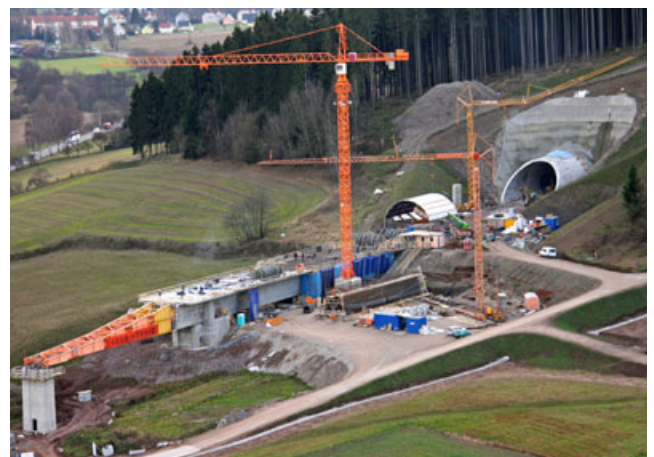
Nordportal Tunnel Tragberg mit Übergang zur Ilmtalbrücke
