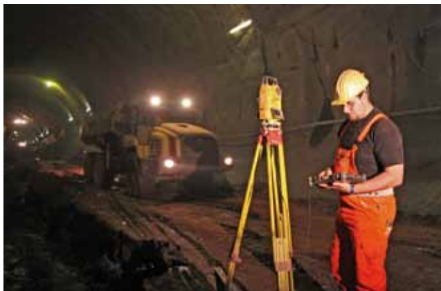
Vermessung im Tunnel Müß, 2008
