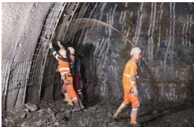
Bewehrung für die Außenschale, Tunnel Baumleite, 2010
