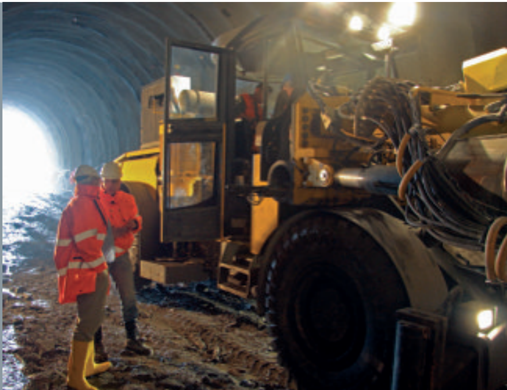
Titelfoto: Zwischenangriffstollen bei Möhrenbach mit Baustelleneinrichtung, 2009
