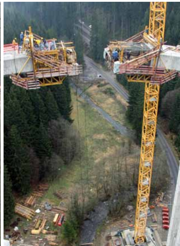
Bauzustand kurz vor dem Bogenschluß, 2010
