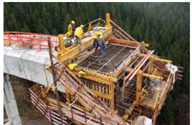
Bauzustand kurz vor dem Bogenschluß, 2010
