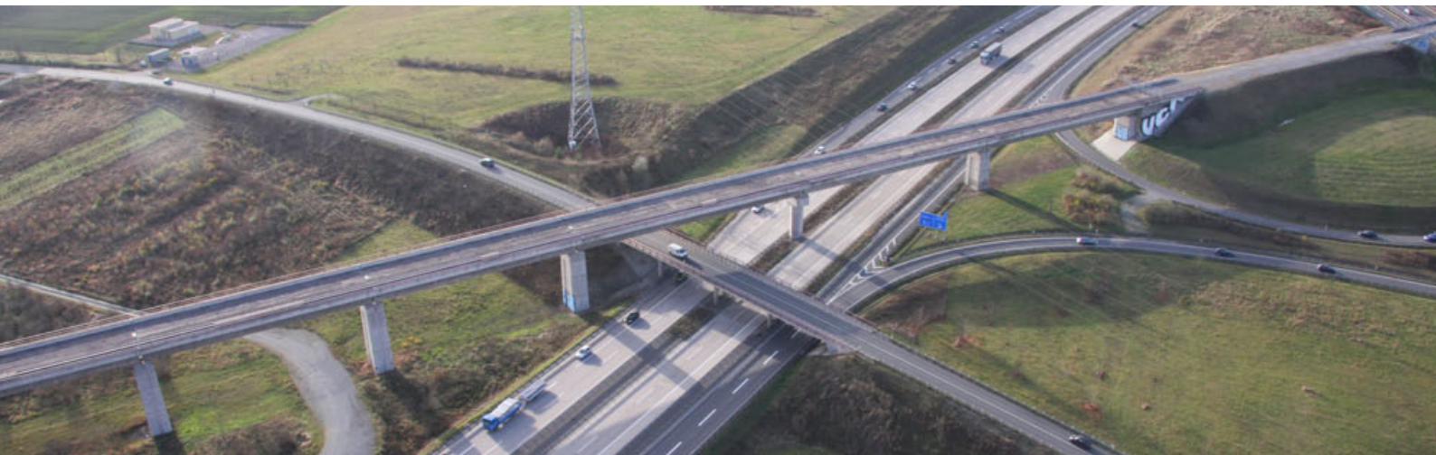
Geratalbrücke bei Ichtershausen
