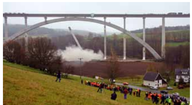
Der Bogen steht frei, Sprengung der Hilfspfeiler, 2010
