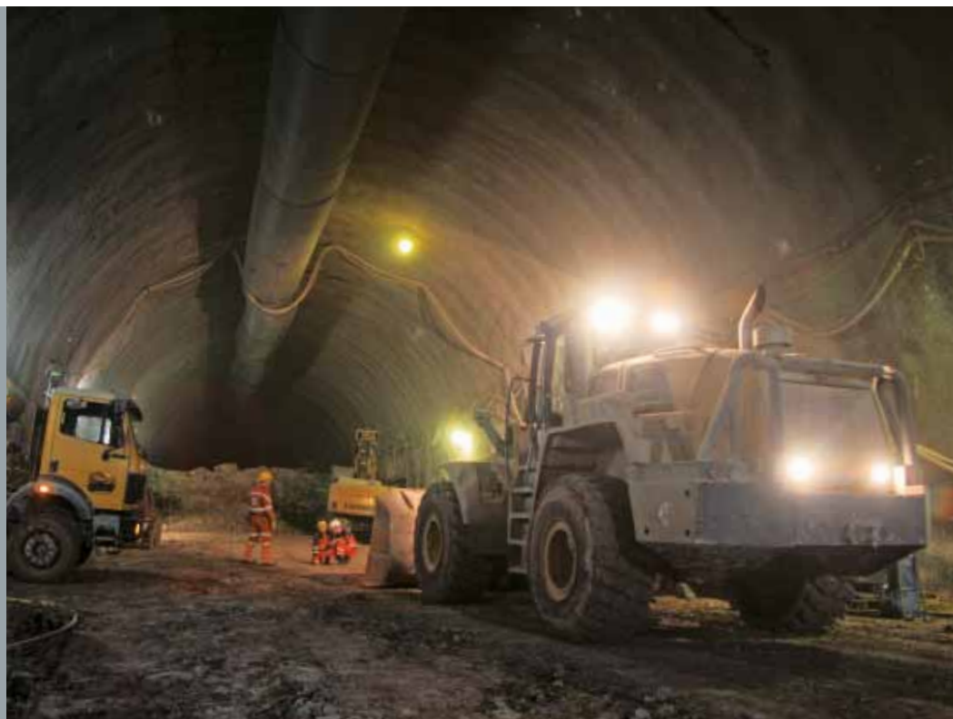
Im Tunnel Feuerfelsen Titel: Tunnel Rennberg Südportal
