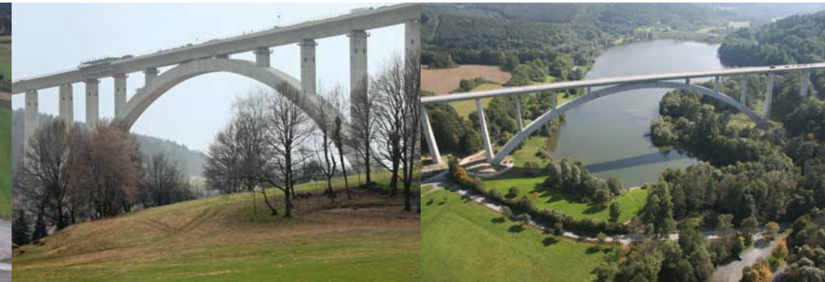
Schonung des Talraumes durch weitgespannte Brückenbögen, Grümpentalbrücke, Talbrücke Froschgrundsee
