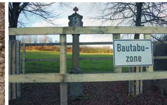
Geschützte Bereiche während der Bauphase (Tunnel Eierberge)
