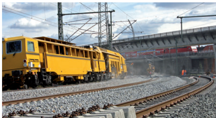
Neue Gleise an der Schwabacher Straße
